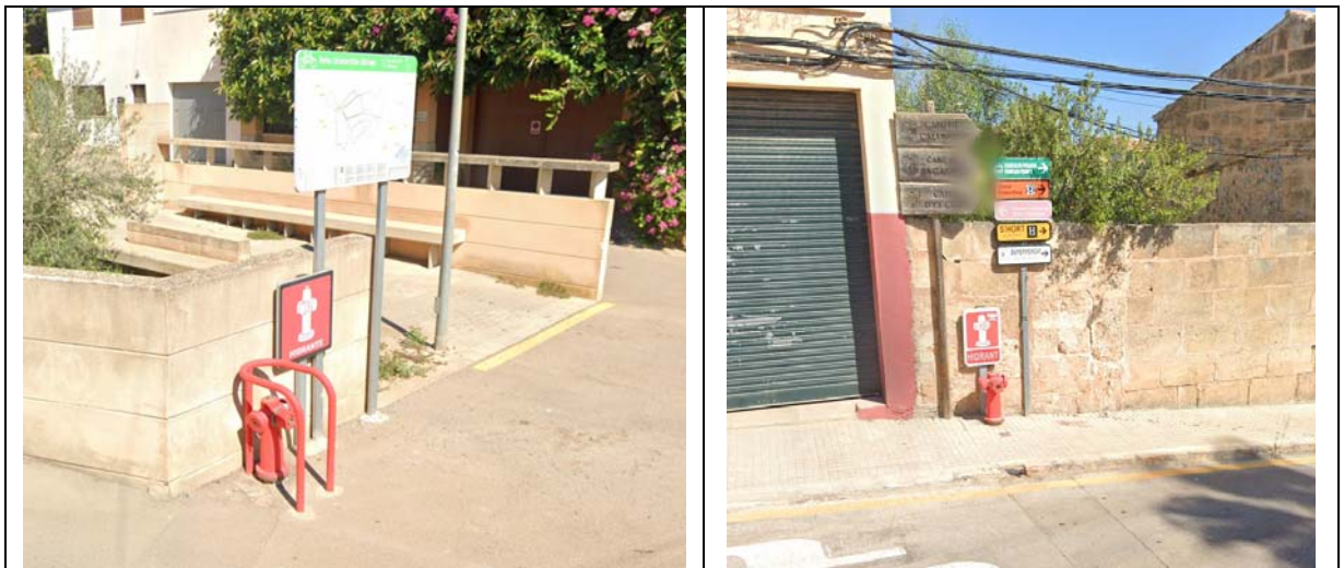
Hidrant al carrer Maria, al costat del centre de recollida selectiva de residus municipals, i hidrant en el carrer del Sol.
